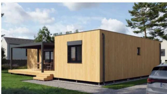
21 - Double T wood 94 m 2 rovná střecha
